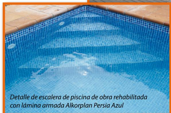
Detalle de escalera de piscina de obra rehabilitada con lámina armada Alkorplan Persia Azul
